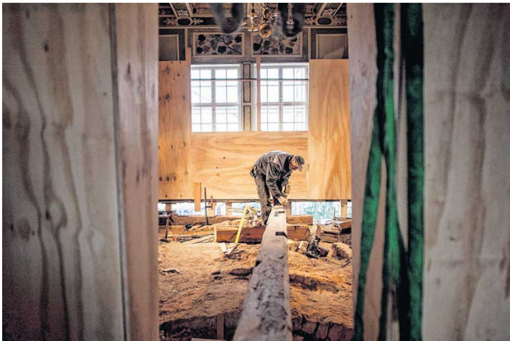
Andreas Schuricht von der Firma „Gefüge und Gefache Zimmerei“ muss millimetergenau arbeiten. Einige Balken konnten erhalten werden, andere mussten durch 200 Jahre alte Balken aus dem Altholzhandel ersetzt werden. Fotos (3): Martin Förster
